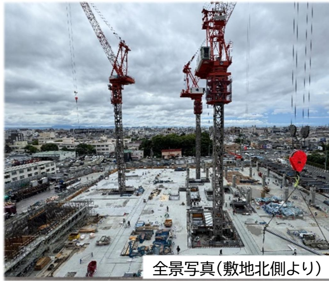
現場写真(2階) 2階の金属製床版を敷設し、コンクリート打設
